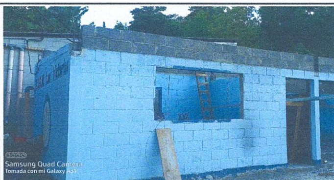
Foto 3: cambio de ventana, vidrios y colocacion de balcón, parte de enfrente del aula 4 y 5
