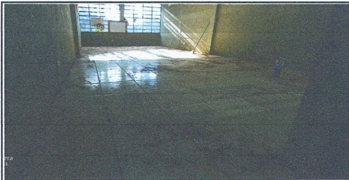
Foto 7: colocación de piso ceramico del aula 1
