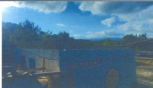
Foto1: cambio de lamina a lamina alucin y colocación de 3 hilada de block
