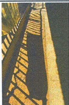
Foto 9: reparación de piso de torta en el patio del establecimiento.
