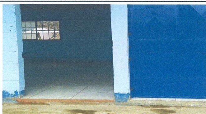
Foto 2: colocacion de piso cerámico en el aula 4 y 5
